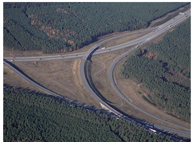
Flächeninanspruchnahme für neue Straßen – Autobahndreieck in Brandenburg Quelle: Jürgen Hohmut / zeitort.de
